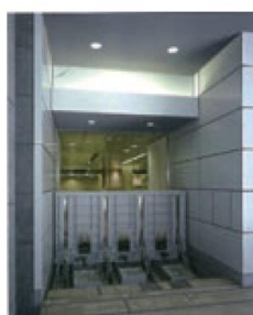
【ビルの出入口の止水板】
