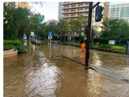
図 冠水した武蔵小杉駅周辺 出典) 朝日新聞デジタル
