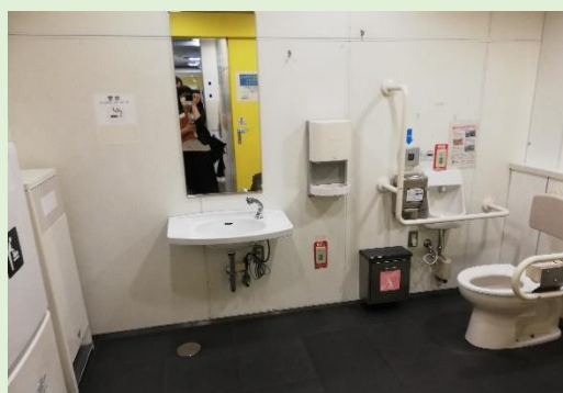
バリアフリートイレの設置
