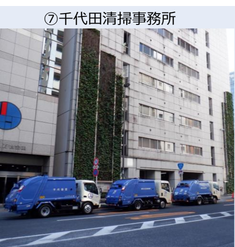
清掃車両駐車スペース不足による、前面道路での清掃車の路上停車
