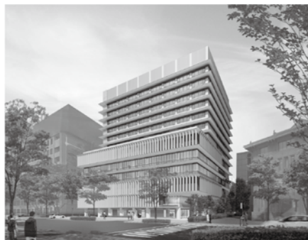
▲施設の外観(イメージ) ～お濠に臨む旧区役所跡地に開設～
