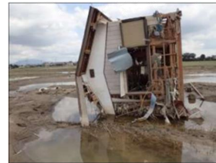
堤防決壊による家屋の倒壊
