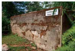
グアム平和慰霊公園内に残る日本軍の飲料水槽跡。小川の水を貯水した
