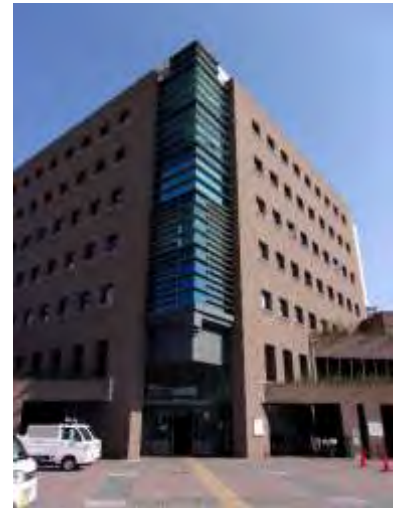
【松原市役所 外観】
