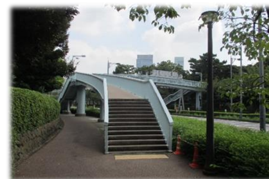
みたけ橋歩道橋
