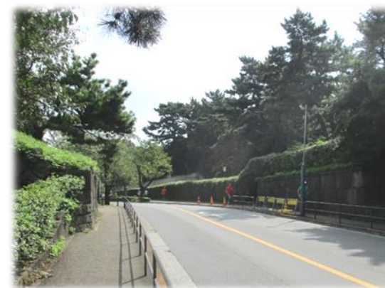
代官町通り 北側土手歩道部
