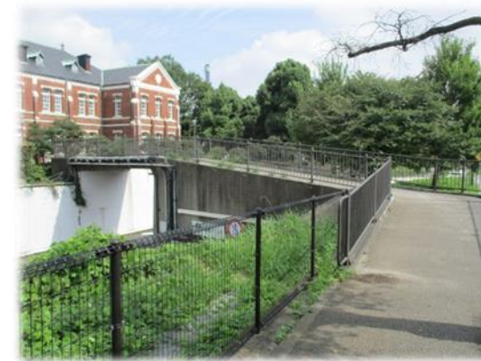
国立近代美術館工芸館前歩道橋
