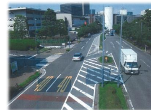
みたけ橋歩道橋上部から竹橋方面
