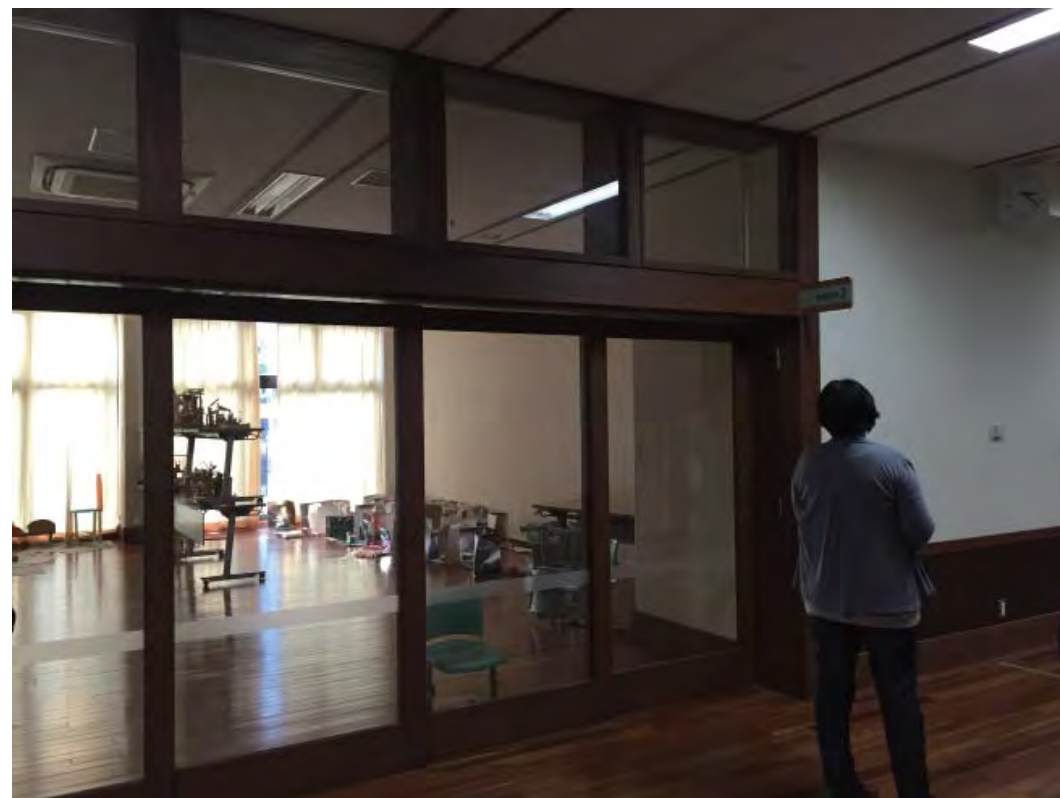
ガラス間仕切りを設置
