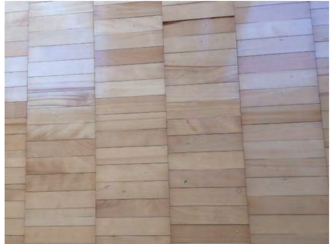
教室床材（フローリング）
