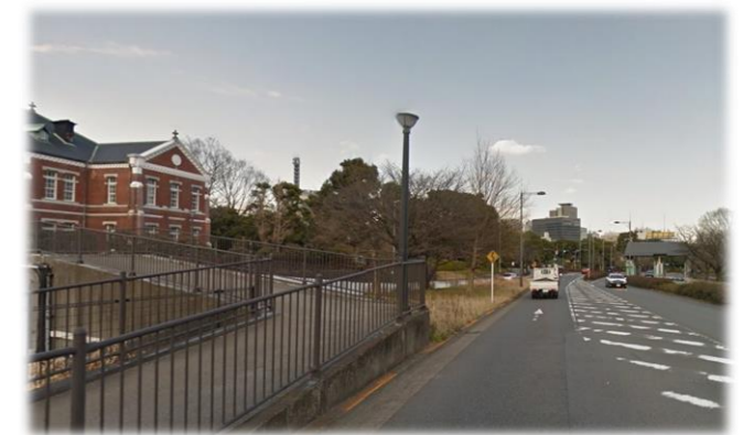
国立近代美術館工芸館前歩道橋
