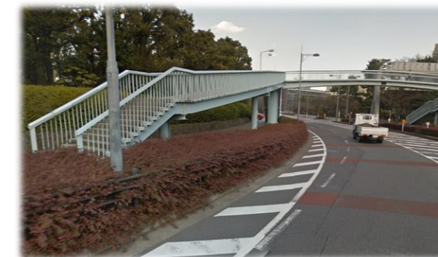
みたけ橋歩道橋
