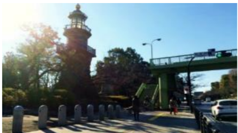
⑩田安門前歩道橋付近歩道(北側)の状況
