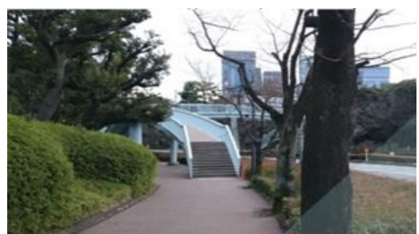
⑦広幅員道路にかかる、みたけ橋の歩道橋
