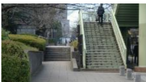
⑧田安門前歩道橋足元(南側)の状況
