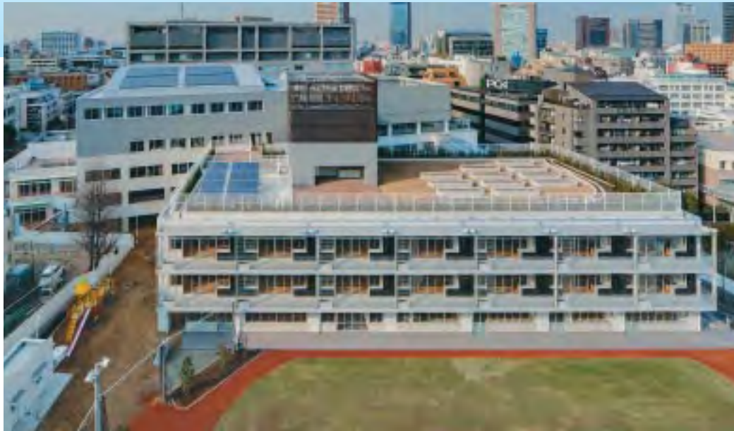
▼図表1 富士見みらい館の施設概要（地上6階・地下1階）
