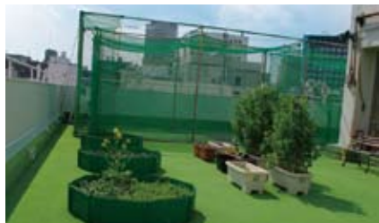
▲高齢者センターの屋上
