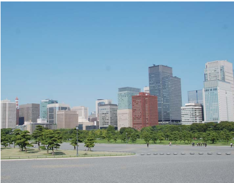
▲海風を皇居に誘導する丸の内エリア
