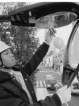
▲ナトリウムランプへの取り替え作業
