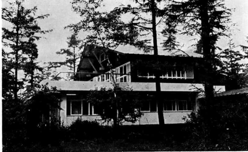
軽井沢高原学校 増築工事完成
