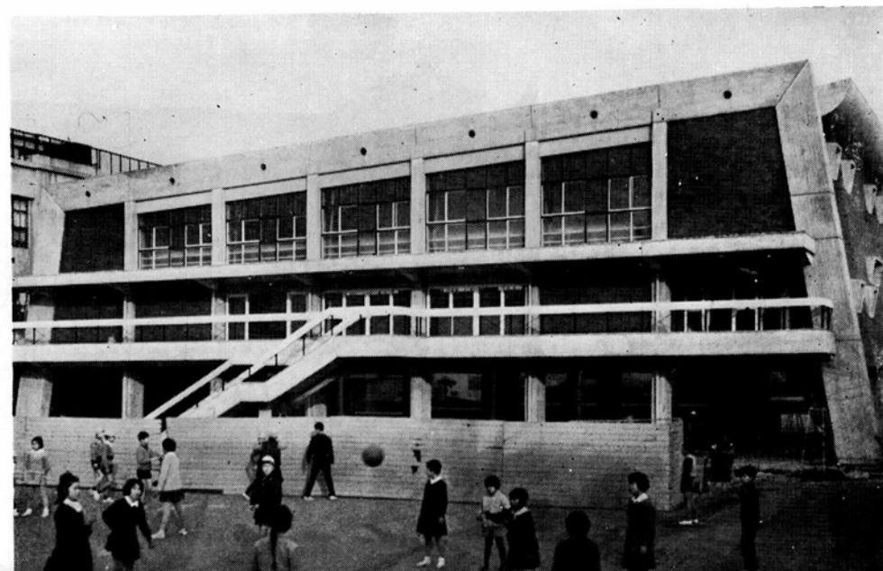
麴町小体育館兼講堂完成
