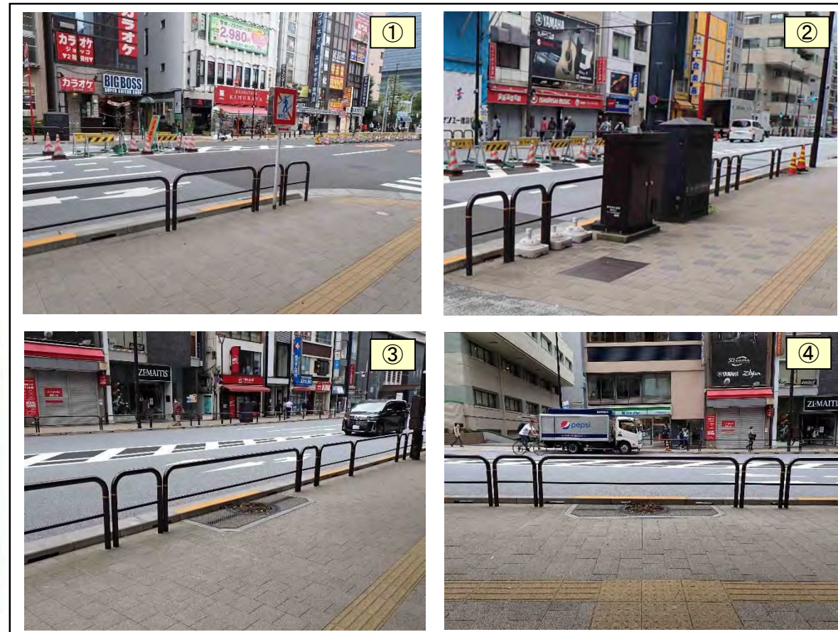
横断防止柵支柱割付の様子(明大通り I 期工事区間)
