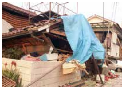
▲阪神・淡路大震災における倒壊家屋 (写真提供:神戸市)
