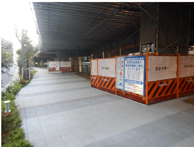
図Ⅲ－３ 日本橋川右岸側広幅員歩道上での工事の状況
