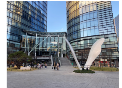
B御茶ノ水淡路町某ビル
