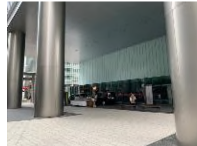
A虎ノ門某ビル
