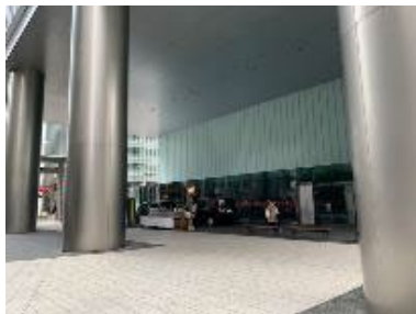
A虎ノ門某ビル
