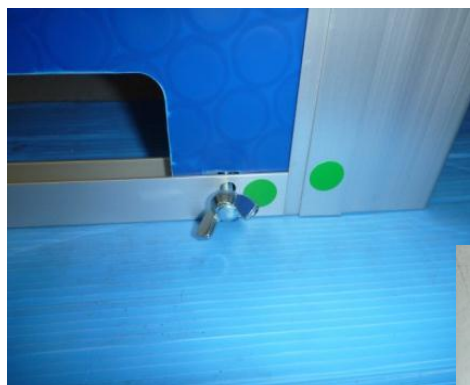
※下のバーをネジで止める。(上部バーはとめない)
