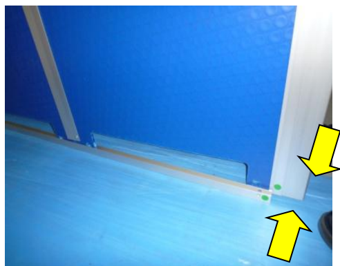
※合わさった部分を 内側からネジでとめる。 (左右3箇所ずつ 計6箇所)
