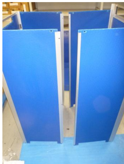
※(マンホールの上に)囲い(2枚)を向かいあわせて立てる。
