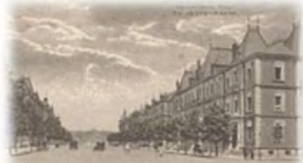
一丁倫敦と呼ばれた日本初のオフィス街 (馬場先通り)
