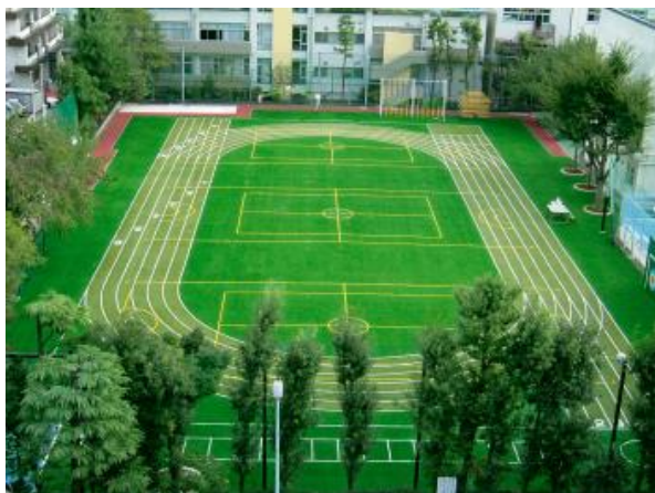
渋谷区立神南小学校（平成22年施工）
