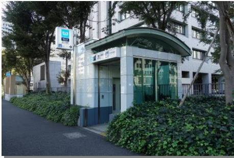
地下鉄のエレベーター(霞が関)
