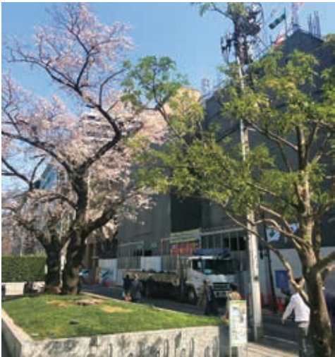
建設が進む施設(3月末撮影)。春には施設前の見事なさくらが目を楽しませてくれます。
