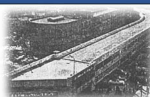
首都高速道路（外濠の埋め立て）
