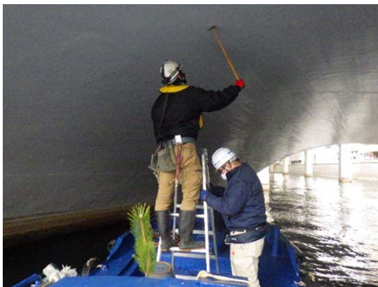
写真 § 2.① 船舶を使った打音点検
