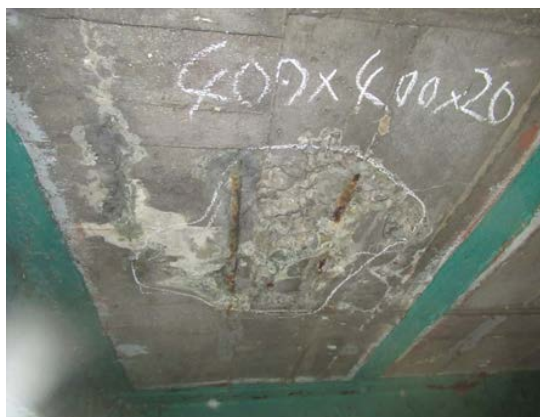
写真 § 2.③ 後楽橋 床版剥離・鉄筋露出
