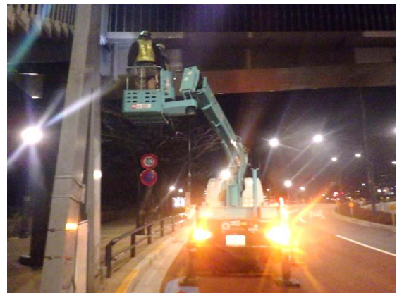
写真 § 2.② 高所作業車を使った目視点検
