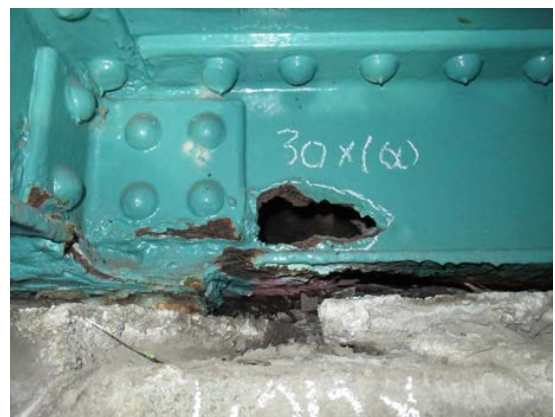
写真 § 2.④ 雉子橋 横桁腐食、変形・欠損
