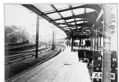
昭和7(1932)年に開設された飯田橋駅
