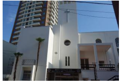
東京ルーテルセンタービル
