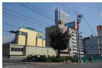
橋詰広場(小石川橋と三崎橋)
