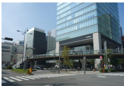
土地区画整理事業で整備された駅前広場と商業・業務施設
