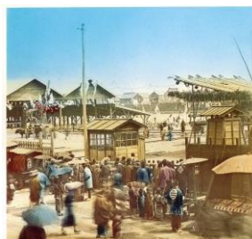
万世橋貨物取扱所開設 [明治18(1885)年]
