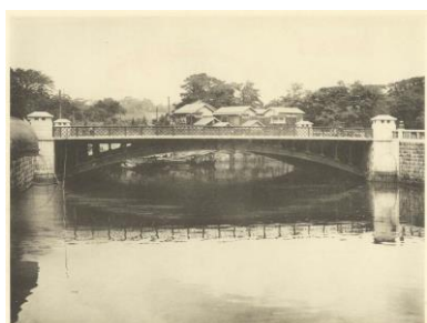
震災復興橋・雉子橋
