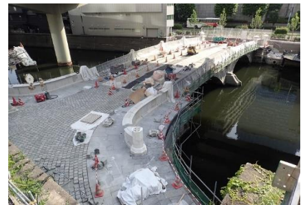
▲修復工事の様子
