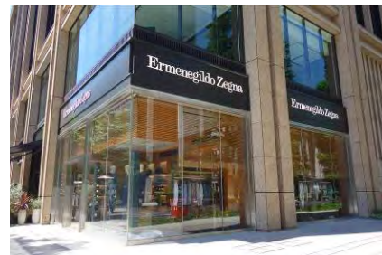
周辺と協調した壁面利用広告物により、しなやかな印象の街並みが形成された例
