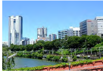
外濠（市ヶ谷～飯田橋間）
