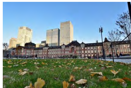
東京駅丸の内駅舎（復原）
