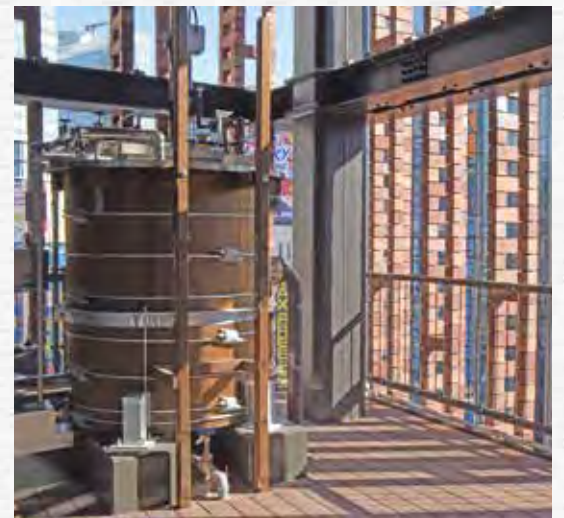
▲屋上で集水した雨水を8階のタンクに貯水し、レンガのシェードを通して植物が生育するエリアへ保水を行っています
