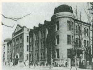
府立東京商工奨励館 外観
