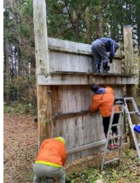
設置しているエレメント
