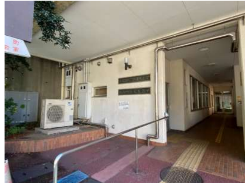
【南棟B 1階外壁石綿除去前】
