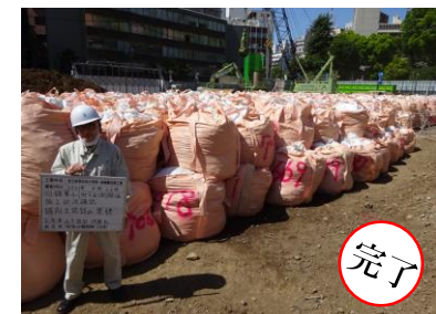
【C】旧錦華小学校 (昭和元年築) アスベスト混入土 袋詰め
