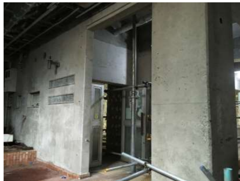
【南棟B 1階外壁石綿除去後】
