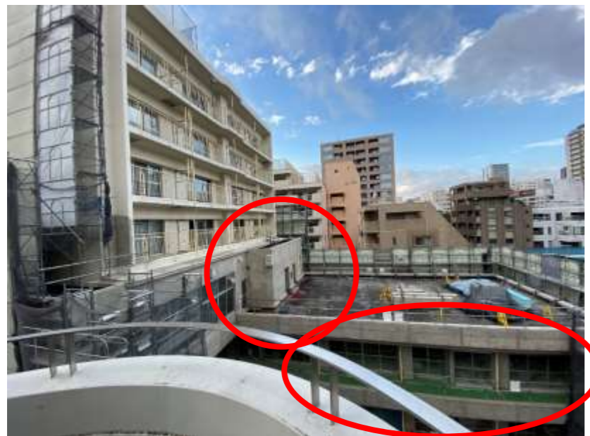
【南棟低層部外壁石綿除去後】
