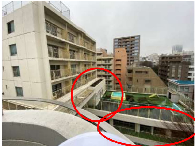
【南棟低層部外壁石綿除去前】
