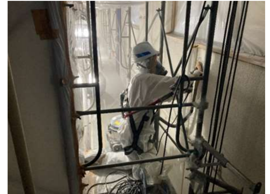
【外壁仕上塗材石綿除去作業状況】
