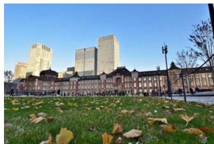
東京駅丸の内駅舎（復原）
