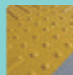
危険箇所や誘導対象施設等の位置を示すブロックを「警告（点状）ブロック」と言います。階段前、横断歩道前、誘導ブロックが交差する分岐点、案内板の前、障害物の前、駅のホームの端等に敷設（ふせつ）されています。
