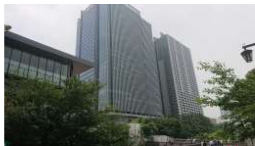
エネルギーや資源利用、自然環境の保全などについて定める地区計画に基づく建築・開発（飯田橋駅西口地区）
