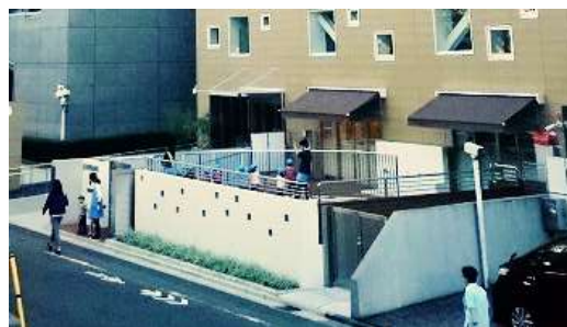
建物低層部に設けられた保育施設（九段北）
