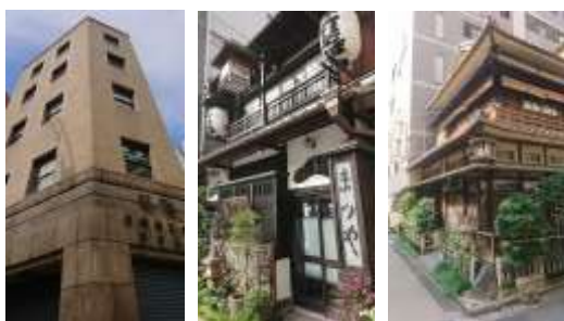
景観まちづくりの重要な要素として継承されている建物（神田須田町）
