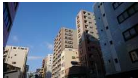
多町大通り沿道の住宅立地
