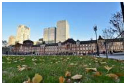
東京駅丸の内駅舎（復原）
