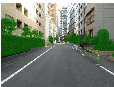
2. 街路樹がない道路でも、道路に面する民間敷地が中高木、生垣を植栽することで緑視率向上に寄与。
