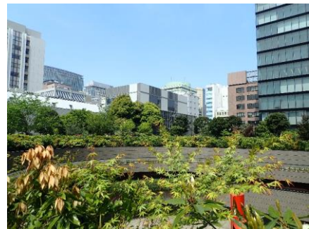
ECOM 駿河台の屋上庭園
