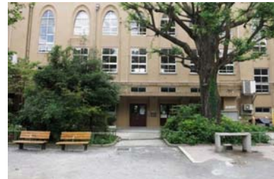
九段小学校 公園側
