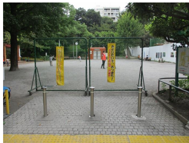
入口部分にパネルを設置
