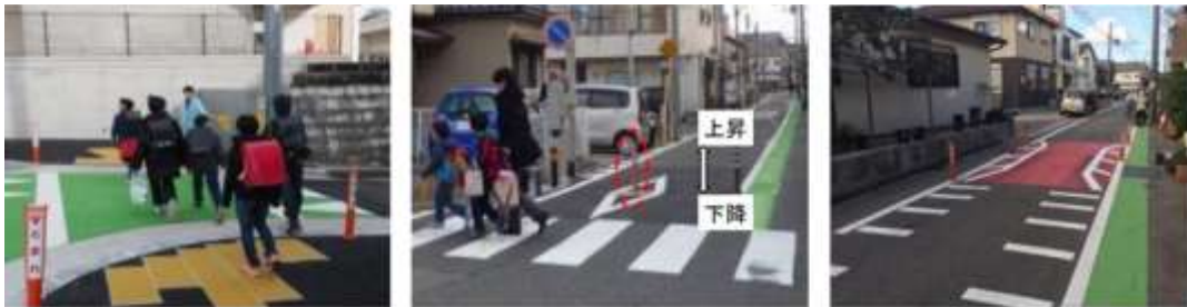
スムーズ歩道を整備 ライジングボラードを設置 狭さく、カラー舗装を実施
