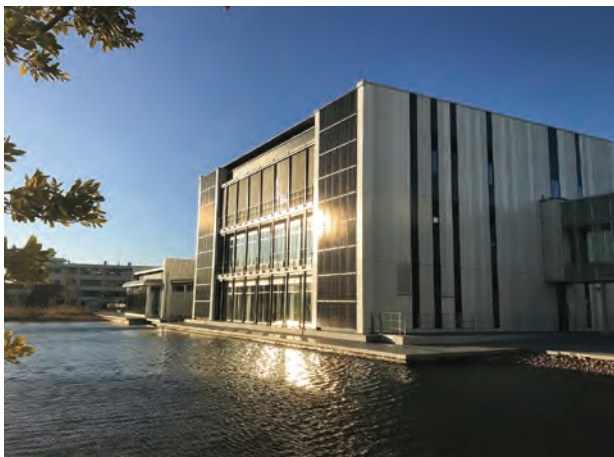
ICI LAB エクスチェンジ棟
