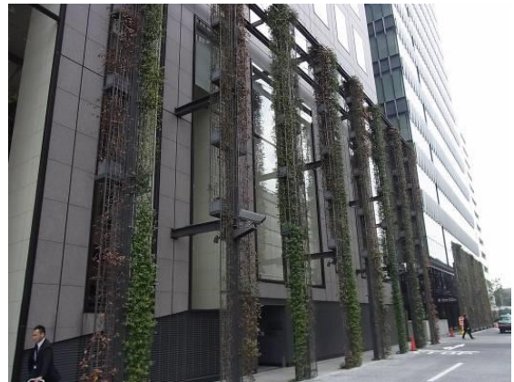
大手町 JA ビル (壁面緑化)
