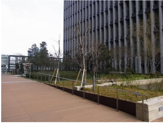
大手町 JA ビル (屋上緑化)
