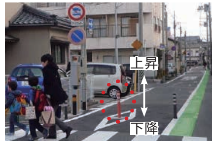
ライジングボラードを設置
